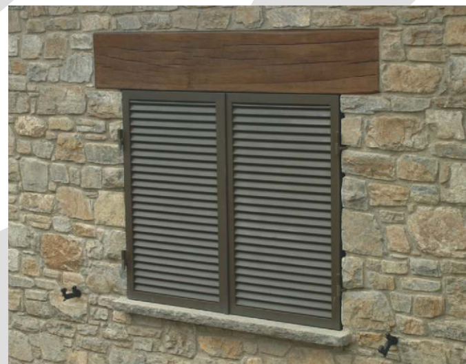
Venetiana en obra rústica
